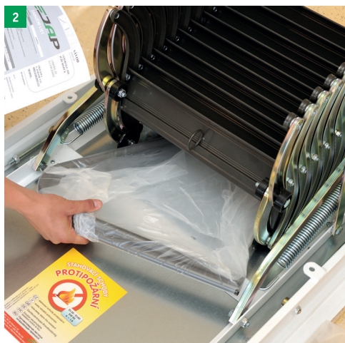
2 kontrola dodaného typu a rozměru stahovacích schodů
