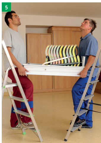
2 kontrola dodaného typu a rozměru stahovacích schodů
