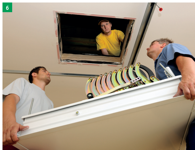
6 dvě osoby vyzvednou schody do stavebního otvoru
